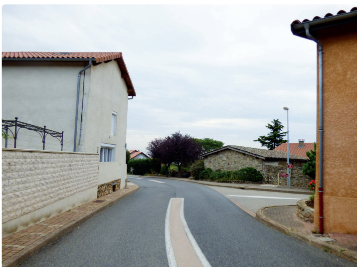
Travaux de sécurisation prévus au 1 er semestre 2018
